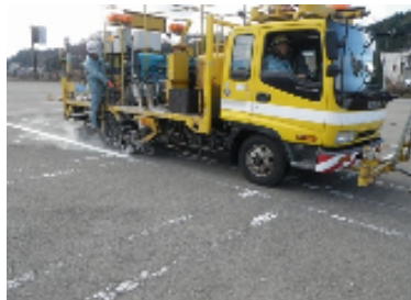
散布状況 1(マーカー車施工時)
