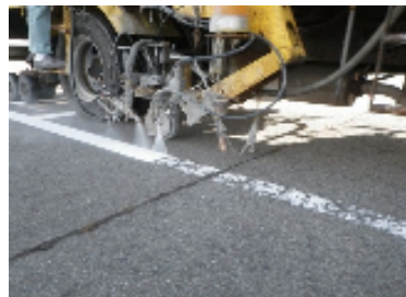
吐出部及び散布部の状況
