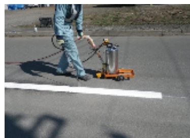
散布状況 2(人力施工時)
