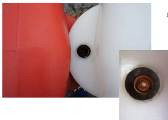
② 接続パイプが貫通できるように、位置を調整します。
