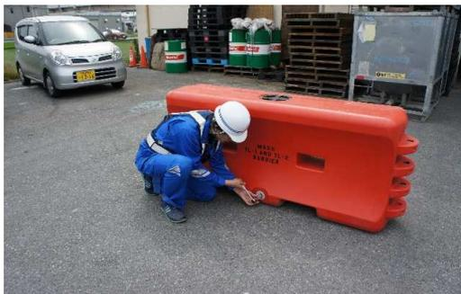
⑥ 時計回りに回して締め込みます。
