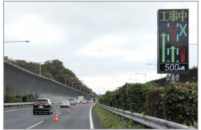
標準タイプ(ソーラー電源)の設置例
