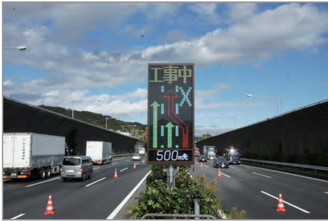
標準タイプ(ソーラー電源)の設置例
