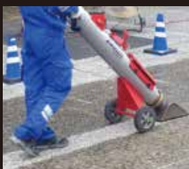
防水施工の下地処理
